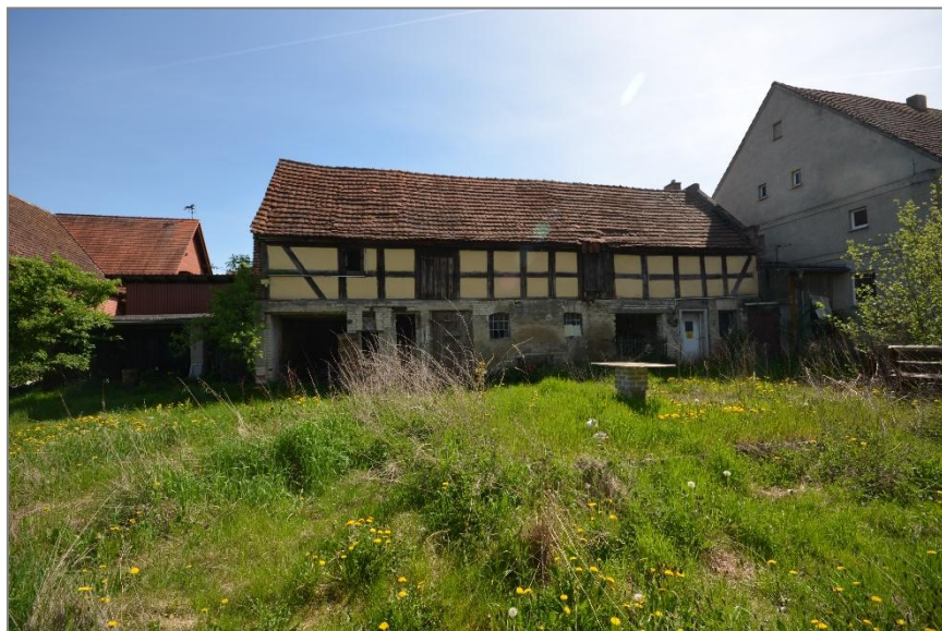
Nebengebäude Stall rechts
