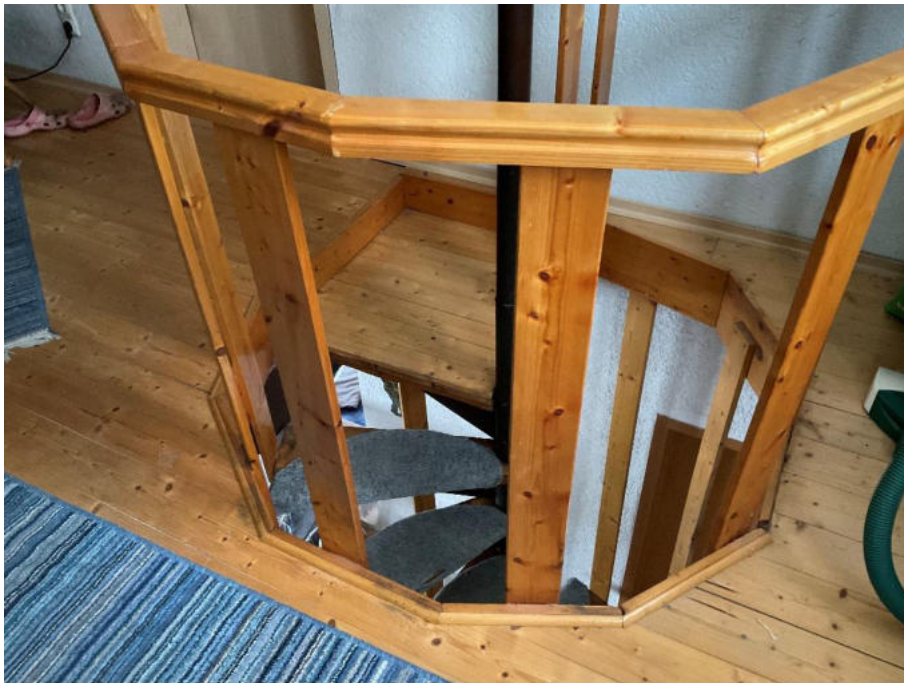
Wendeltreppe – Zuwegung vom EG zum DG
