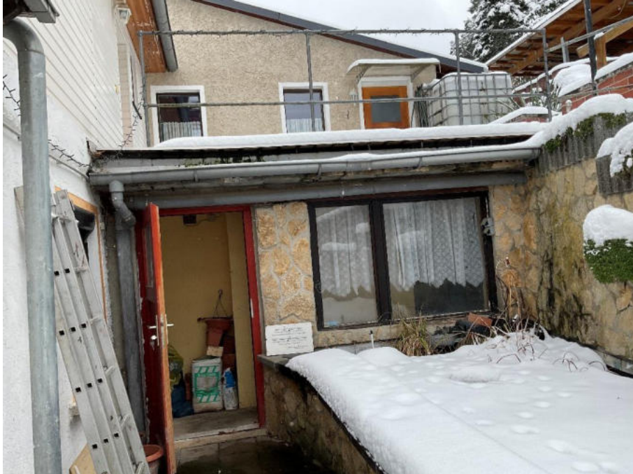
Ansicht Südteil des Gebäudes. DG -Einliegerwohnung
