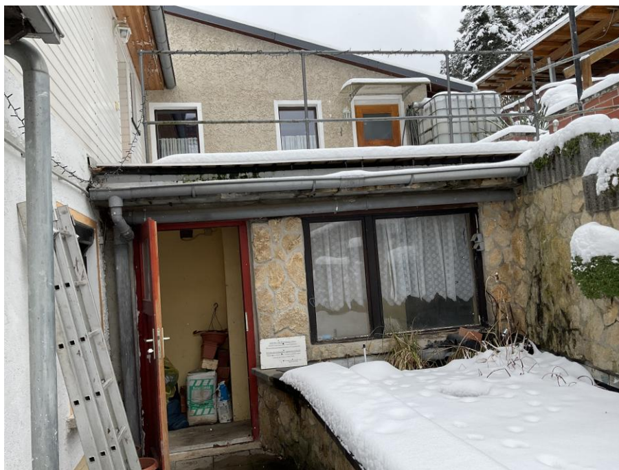
Ansicht Nordseite, DG – Einliegerwohnung
