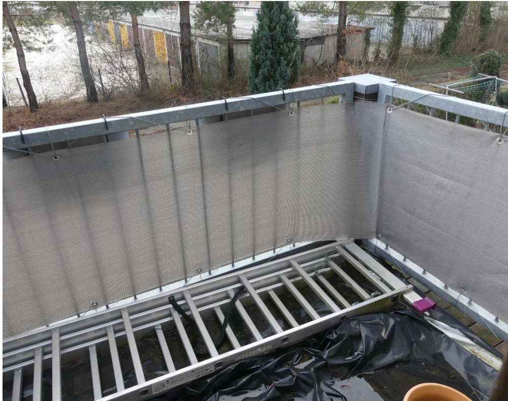
Foto 16: Balkon im Obergeschoss
