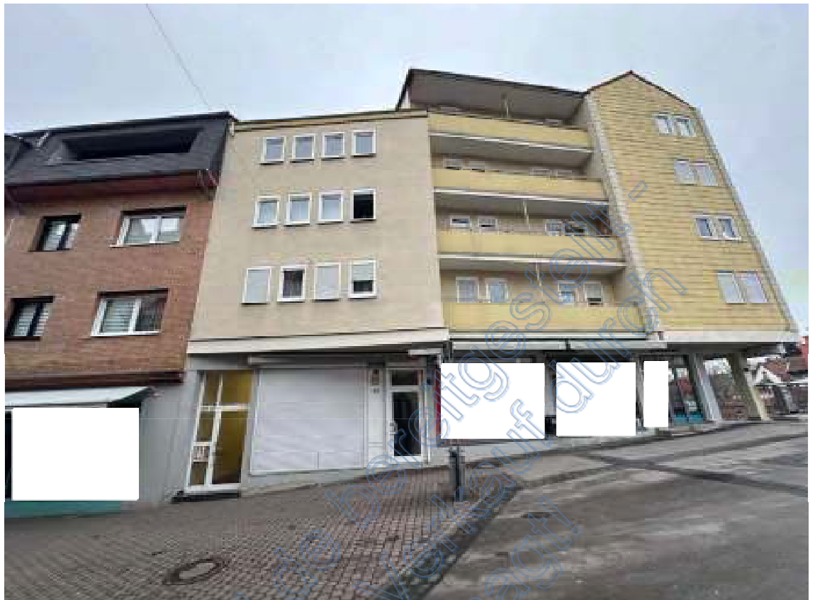
Ansicht Mannheimerstraße miz Eingangstür
