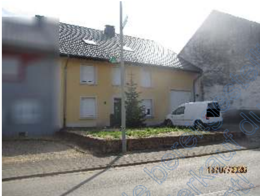
Bild 1: Ansicht von links
