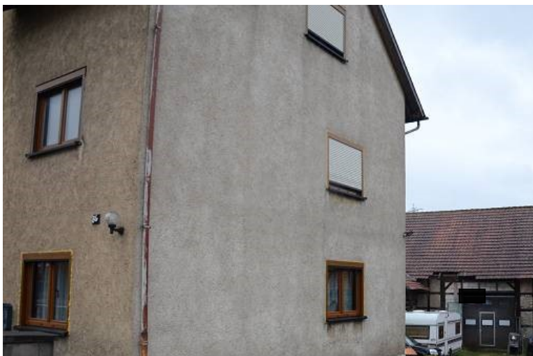
Foto 3 WESTANSICHT MIT HOFZUFABRT
