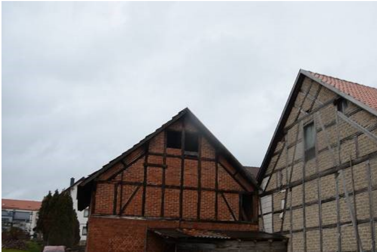
FOTOS 4-5 SCHEUNE QUERBAU UND SCHEUNE LÄNGSBAU
