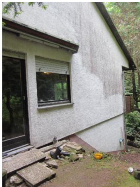
Bild 8: Ansicht West mit rückgebauter Terrasse
