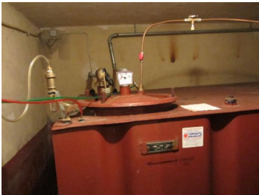
Bild 38: KG: Öltank 7.000 Liter
