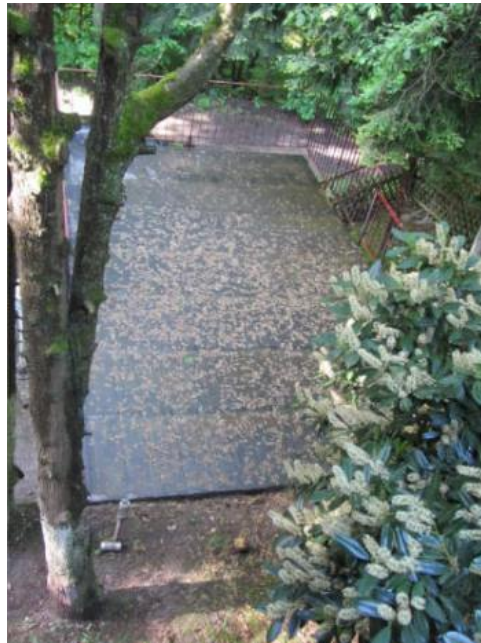
Bild 17: Flachdach der Garage mit bituminöser Abdichtung
