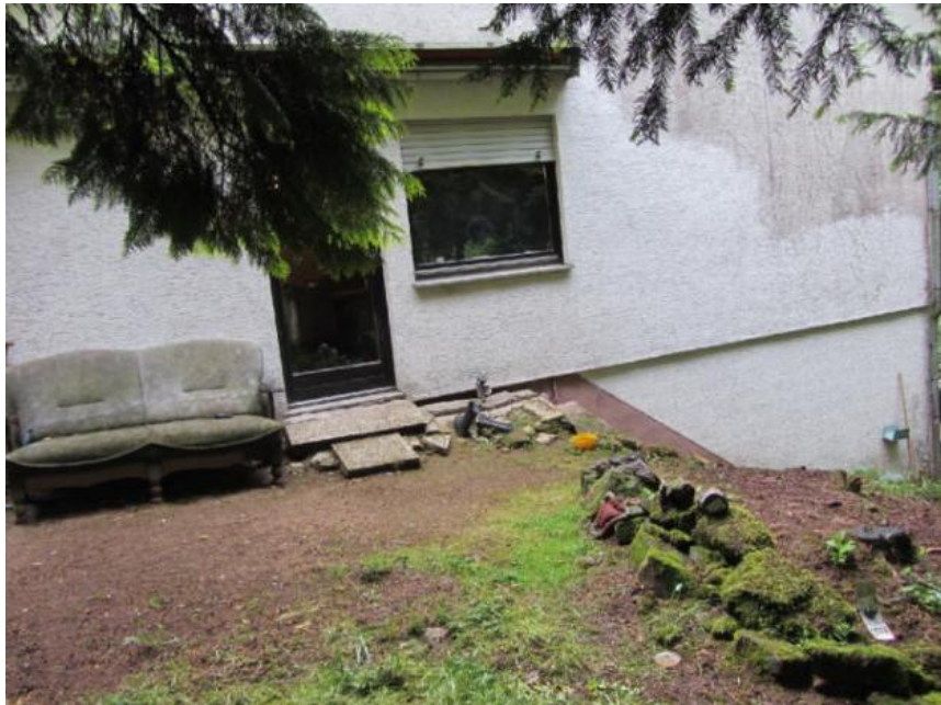
Bild 7: Ansicht West mit rückgebauter Terrasse
