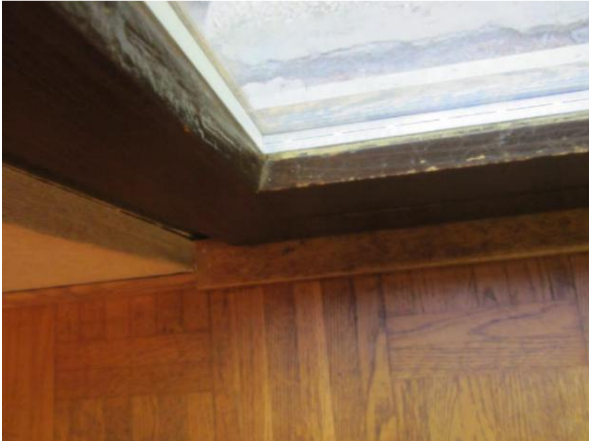
Bild 25: EG: Zustand Fenster aus Holz
