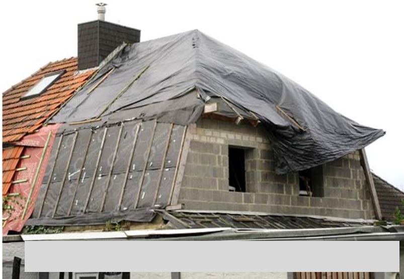
Dachstuhl, Giebel- und Gartenseite
