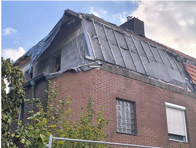
Dachstuhl, Traufbereich und Frontfassade
