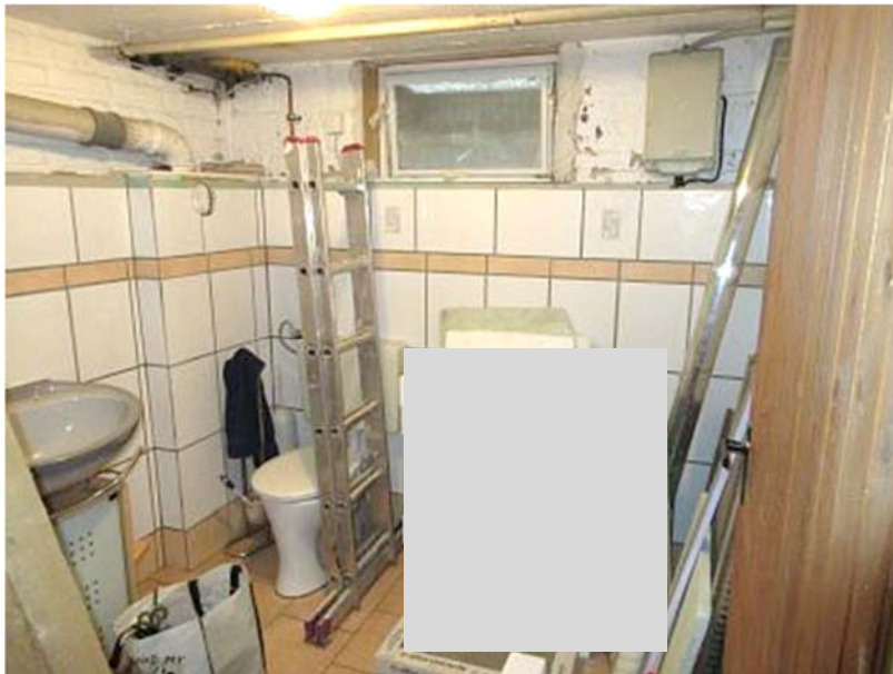
WC in Umbau KG
