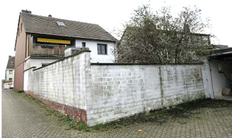
Blick von Garageneinfahrt aus
