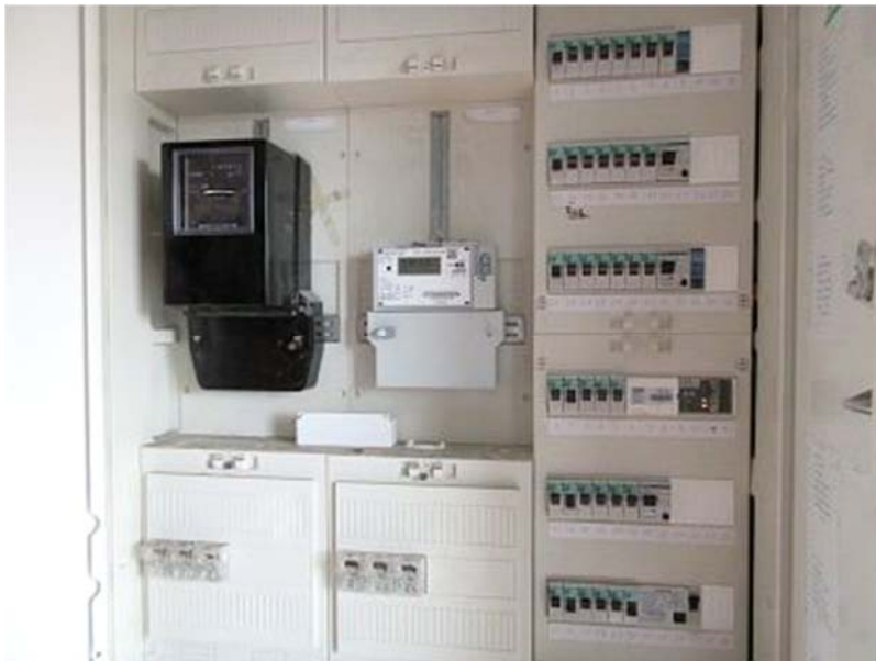
Sicherungskasten / Zähler
