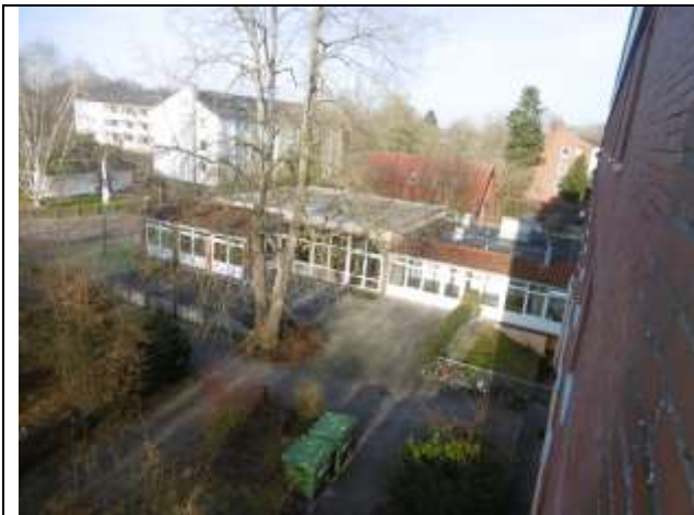
südlich von Gebäudeteil 1
