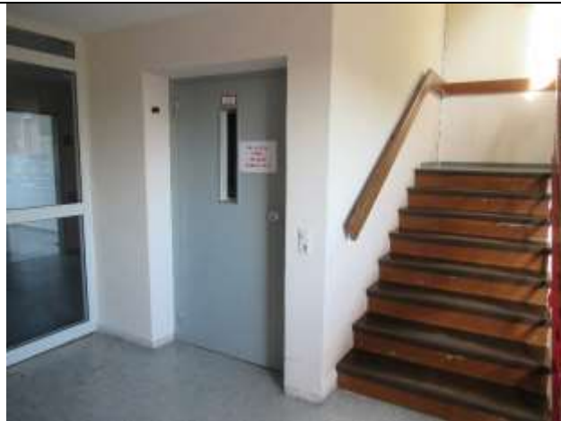
Geb. 2: Personenaufzug (außer Betrieb)
