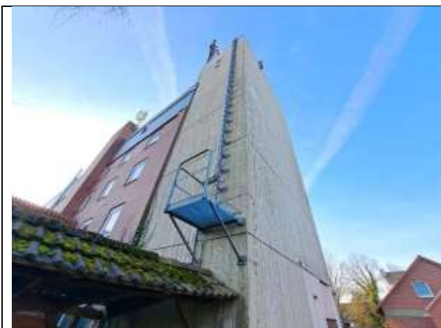
Geb. 2: Nordostseite mit Aufzugsschacht
