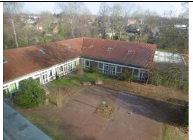
südlich von Gebäudeteil 3
