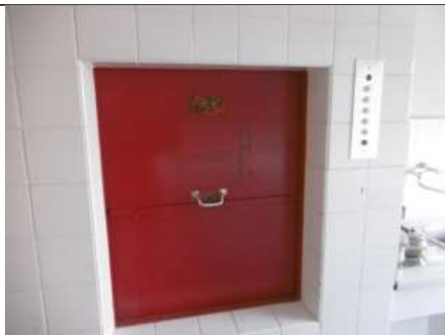
Geb. 2, 2. OG: ehem. Speisenaufzug
