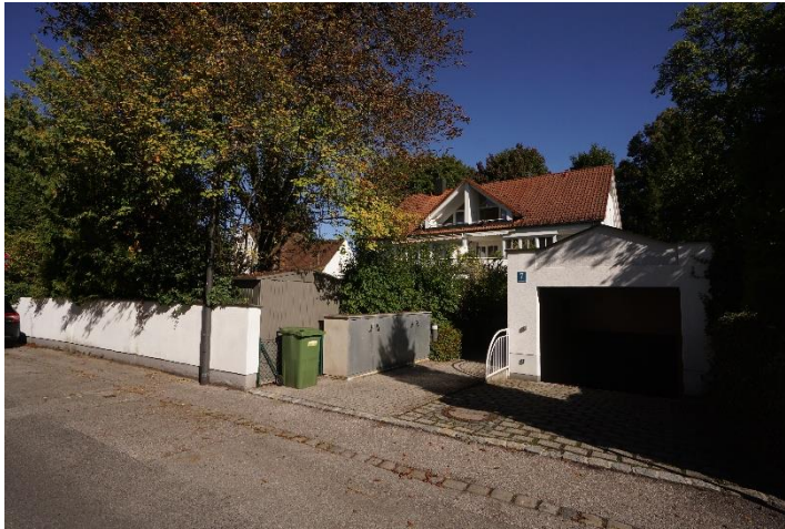
Südansicht Blick von der Karl-Schröder-Straße
