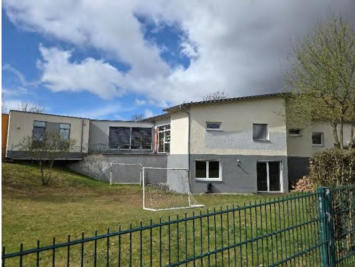
Bild 1 | Ansicht von Südwesten
