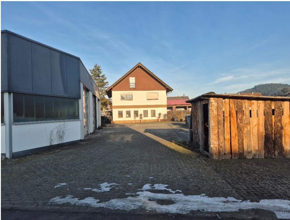
Beschreibung: 05 Wohngebäude Zufahrt
