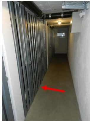
Kellerflur; Kellerabteil Nr. K 33
