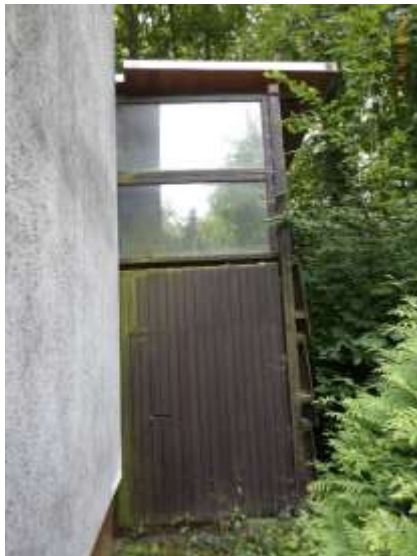
Durchgang zum Schuppen auf Fl.-Nr. 160/4 an der Gebäude-Westseite
